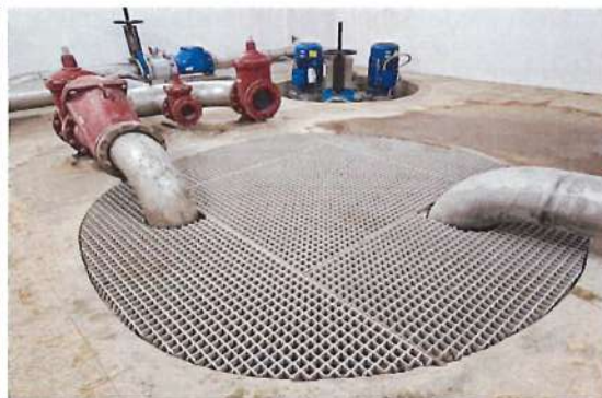
Depois da intervenção
