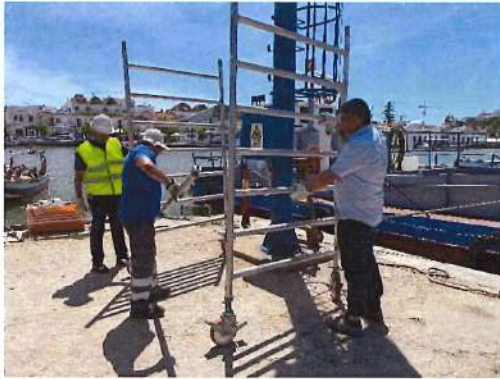
Formação “Montagem e Desmontagem de Andaimos”
