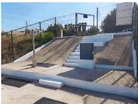
A fotografia ao lado demonstra algum do trabalho que é realizado ao longo do ano pelas equipas de manutenção, no caso trata-se da manutenção da EEAR da Quinta das Salinas I, com a pintura de muros, armário do QE e das tampas de acesso ao poço de bombagem e caixa de válvulas.
