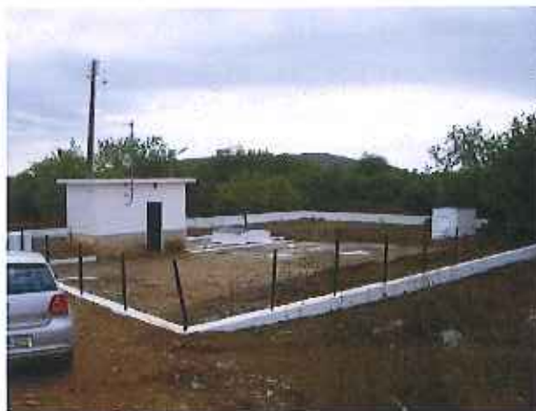
Captação JCS1 - Barrocais após a intervenção de reabilitação.
